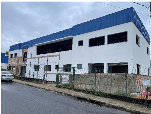
Voorzijde nieuwe gebouw met rechtsonder de bakkerij (november 2024)
